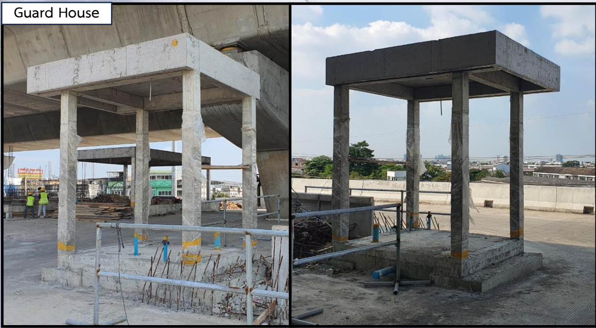
ภาพถ่ายงานก่อสร้างอาคารบริเวณด้านพุทธบูชา (Ramp 5)
