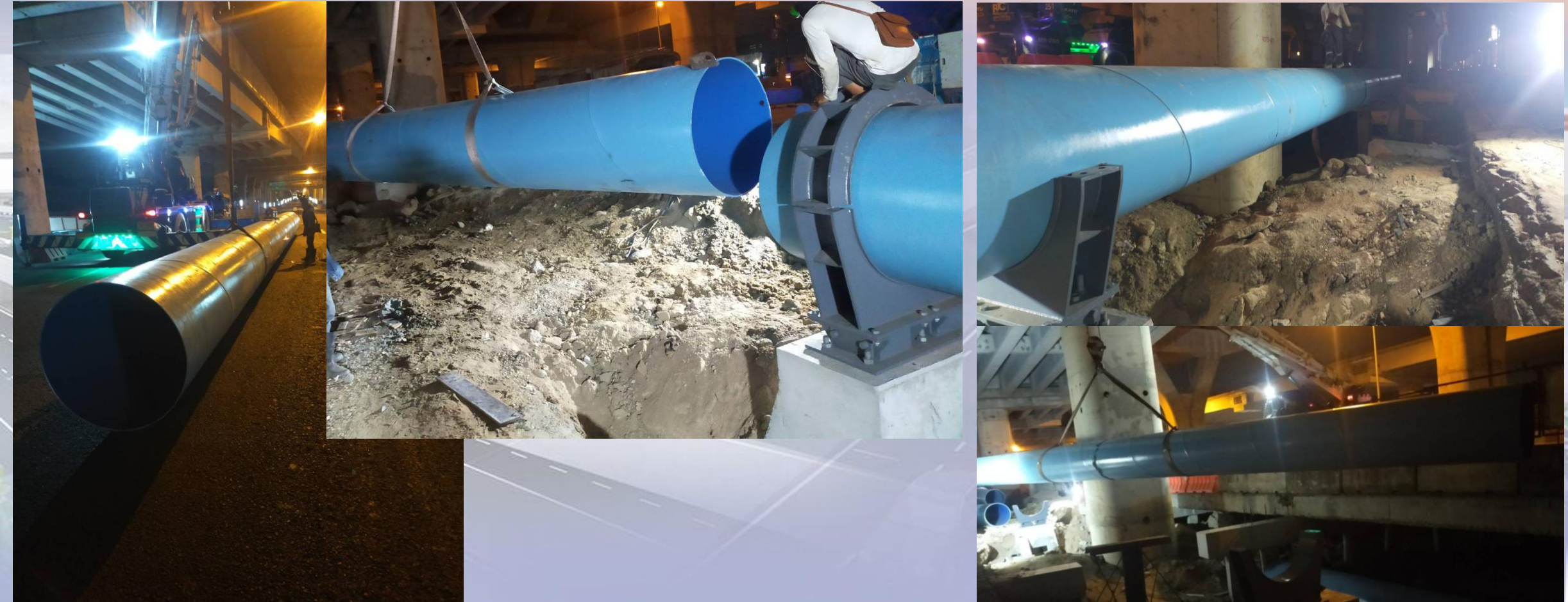
งานวางท่อประปาเหนือดิน ขนาด 1,000 มม. (ต่อเนื่อง) (คลองสนามชัย)
