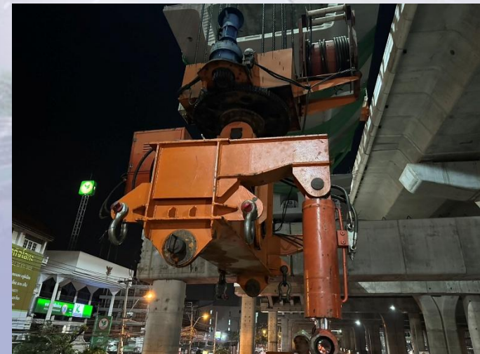
ตรวจสอบสภาพความพร้อมใช้งานอุปกรณ์การยก
