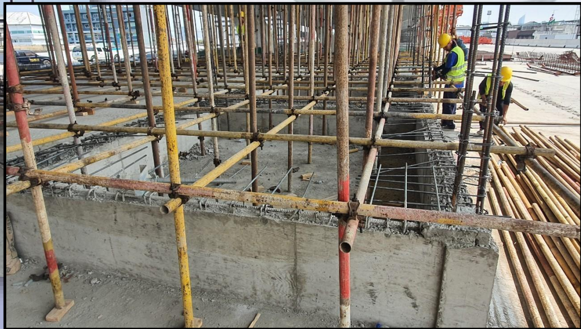
ภาพถ่ายงานก่อสร้างอาคารบริเวณด้านพุทธบูชา (Ramp 5)
