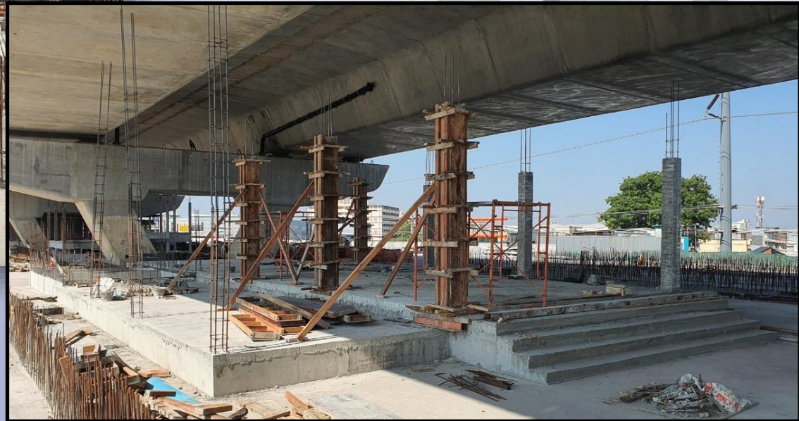
ภาพถ่ายงานก่อสร้างอาคารบริเวณด้านท่าข้าม (Ramp 3)
