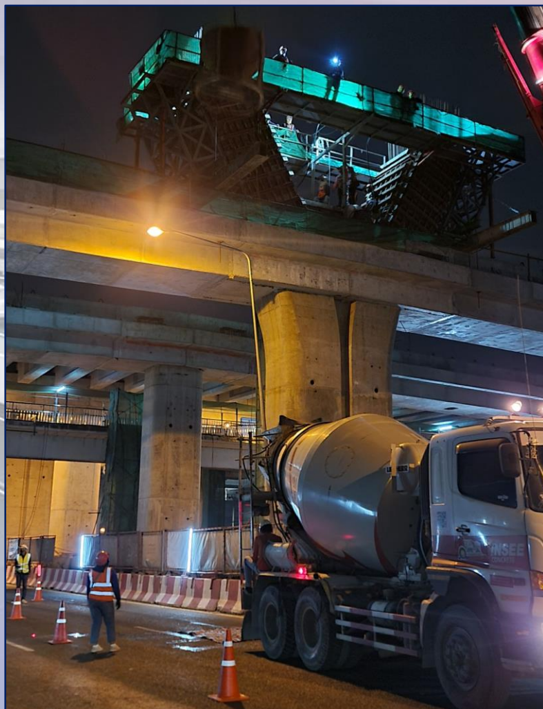
เทคอนกรีต Column Step-Y ที่ MLP07-29C Type YT
