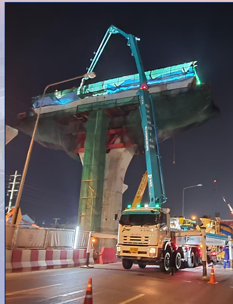
เทคอนกรีต Cross Head ที่ MLP08-08 Type Y
