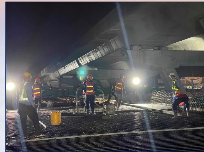
เทคอนกรีต Deck slab ที่ RON5-06 To RON5-07
