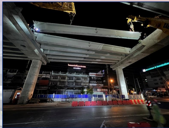
ติดตั้ง I-Girder ที่ RON5-12 To RON5-13
