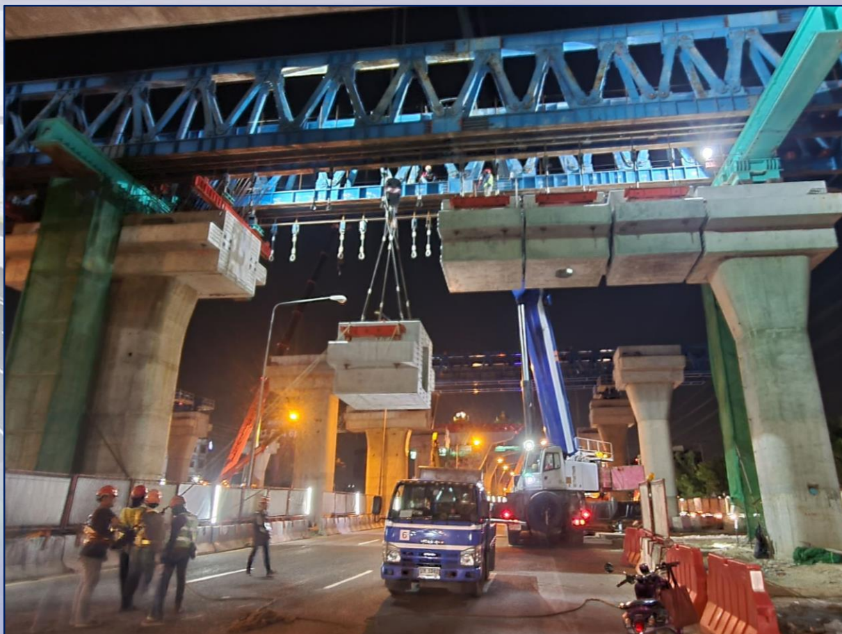
ยกติดตั้ง Portal Beam บริเวณด้านๆ ที่ MLP07-29
