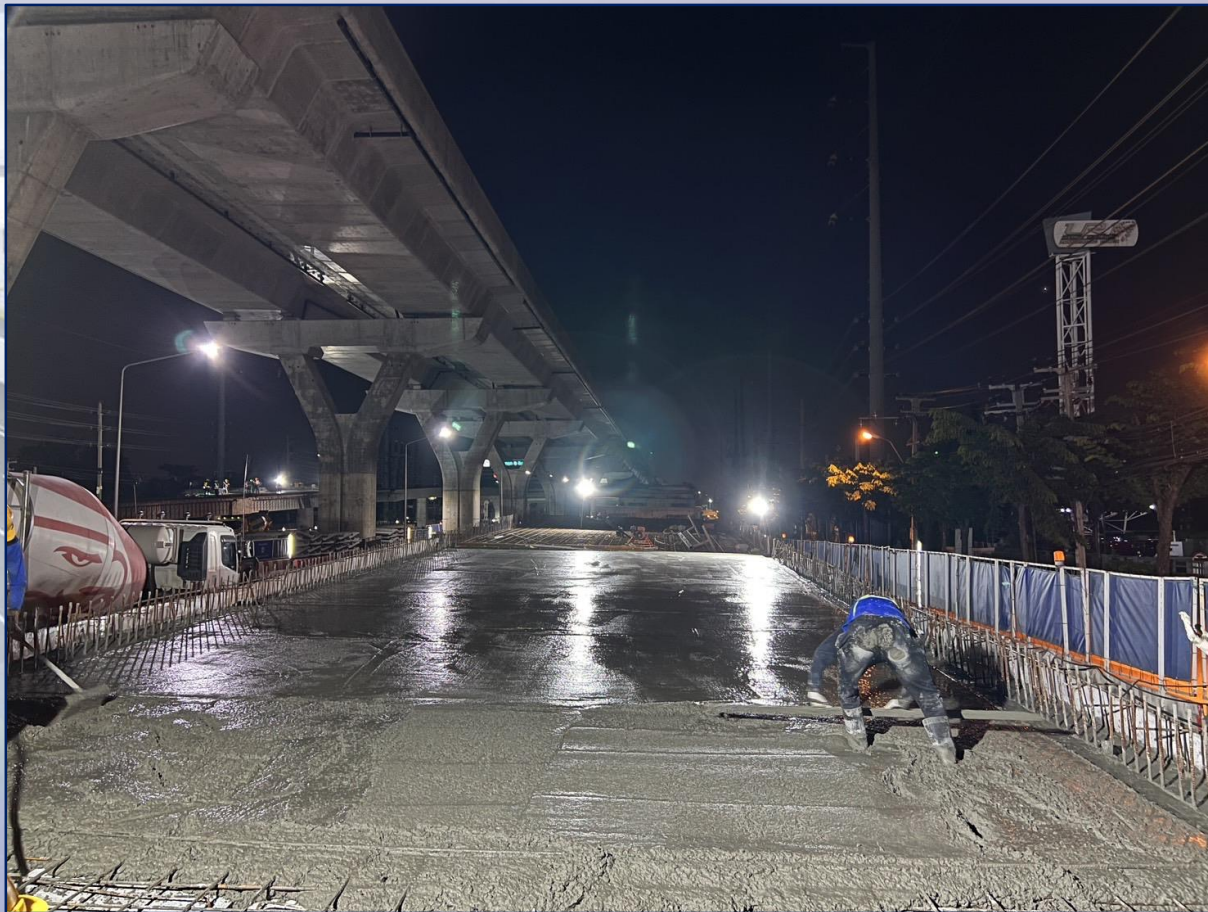
เทคอนกรีต Deck Slab บริเวณด้านๆ ที่ ROF5-20B to ROF5-20D
