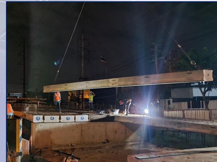
ติดตั้ง Plank Girder บริเวณด้านฯ ที่ ROF3-20B to 20C
