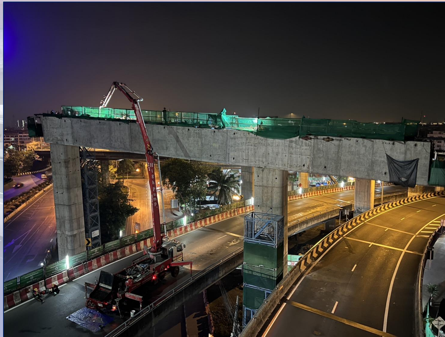
เทคอนกรีต Portal Beam ที่ MLP11-24
