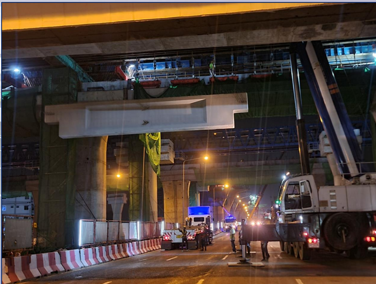
ติดตั้ง I&C Girder บริเวณด้านๆ ที่ MLP07-27 to MLP07-28
