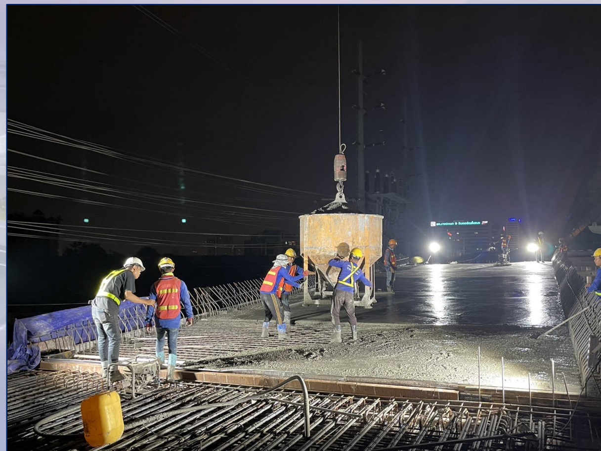
เทคอนกรีต Deck Slab บริเวณด้านๆ ที่ RON5-05 to RON5-06
