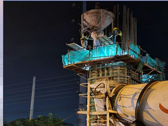
เทคอนกรีต Column Step-2 บริเวณด่านฯ ที่ ROF3-06
