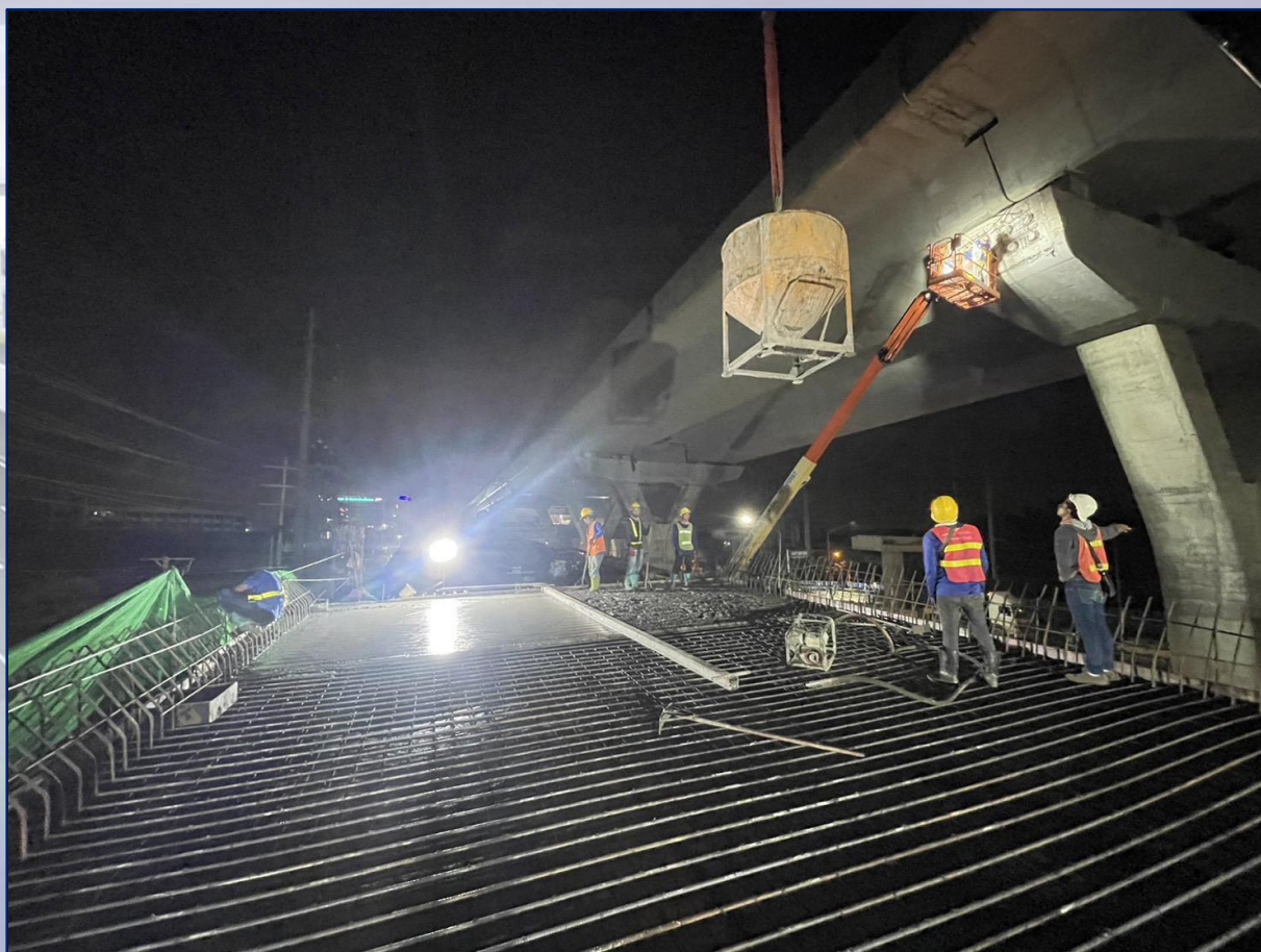
เทคอนกรีต Deck Slab บริเวณด้านๆ ที่ RON5-04 to RON5-05
