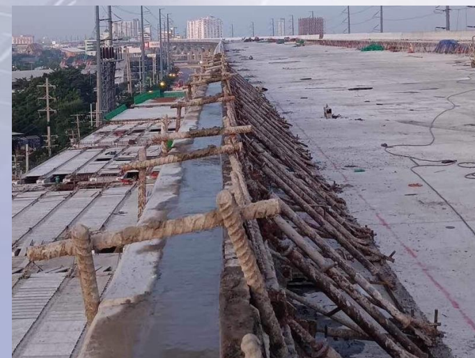
เทคอนกรีต Parapet ที่ Zone 3
