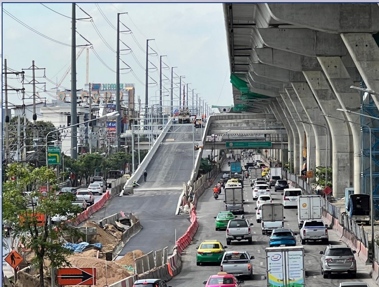
งานก่อสร้างสะพานกลับรถ RAMP 4 ฝั่งขาออก
