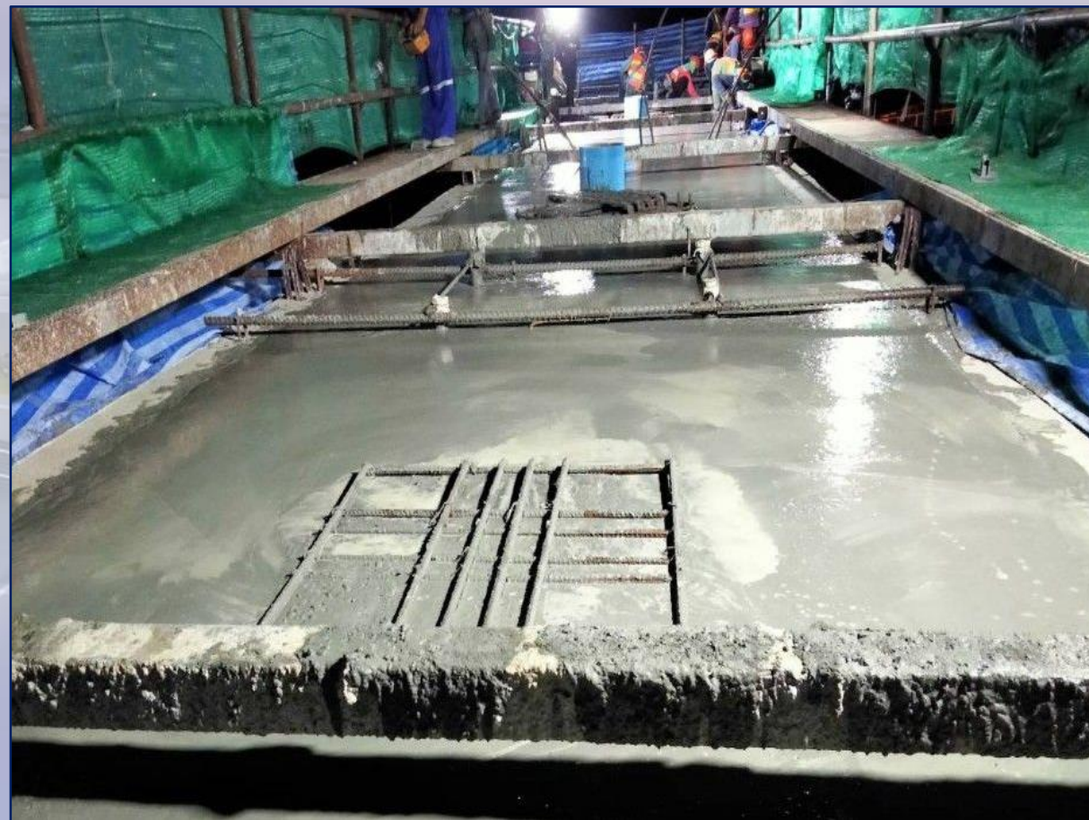
เทคอนกรีต Cross Beam ที่ MLP07-26C
