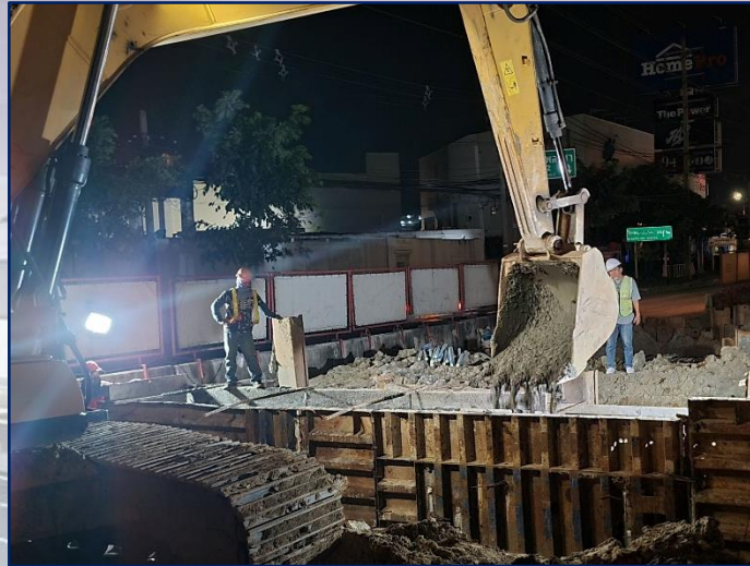
เทคอนกรีต Cab beam บริเวณด้านฯ ที่ ROF3-20E
