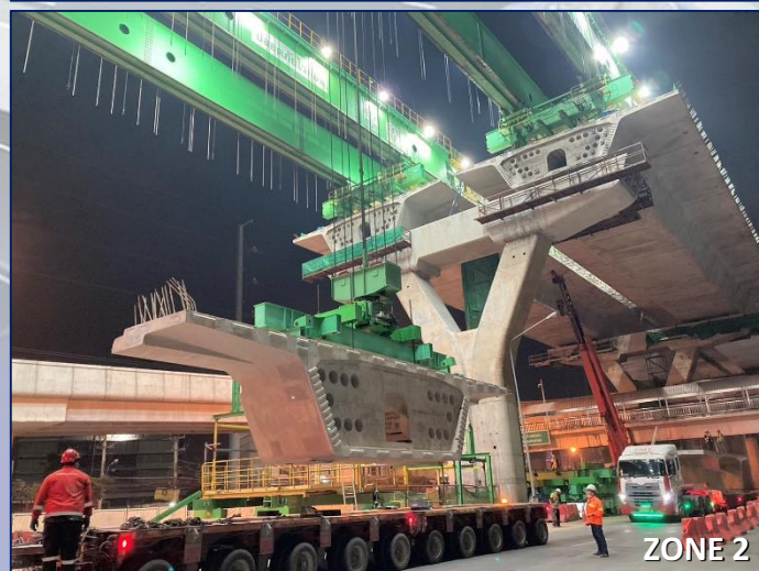
งานติดตั้ง Precast Segmental Box Girder
