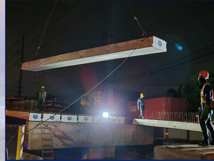
ติดตั้ง Plank Girder บริเวณด้านฯ ที่ ROF3-20A to 20B
