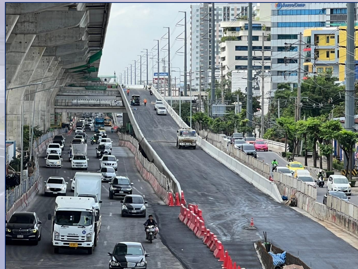
งานก่อสร้างสะพานกลับรถ RAMP 4 ฝั่งขาเข้า
