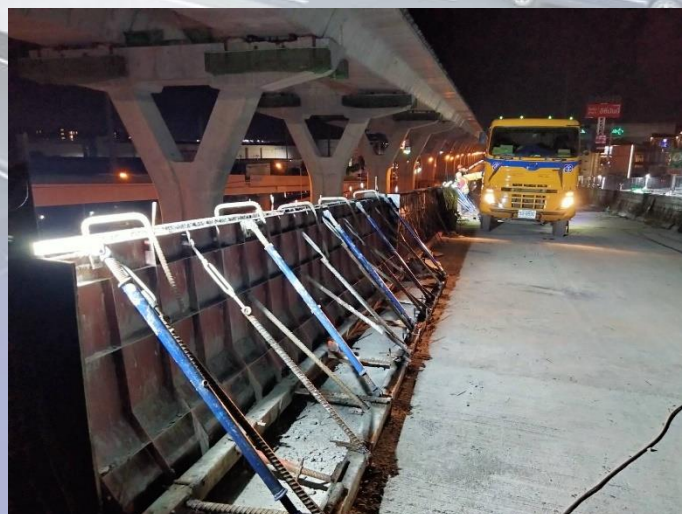
เทคอนกรีต Parapet ที่ Ramp 3
