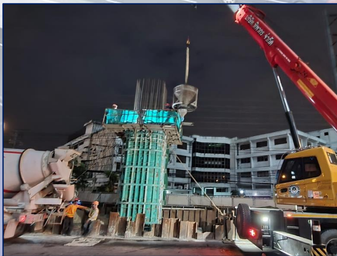
เทคอนกรีต Column Step-1 บริเวณด่านฯ ที่ RON3-19
