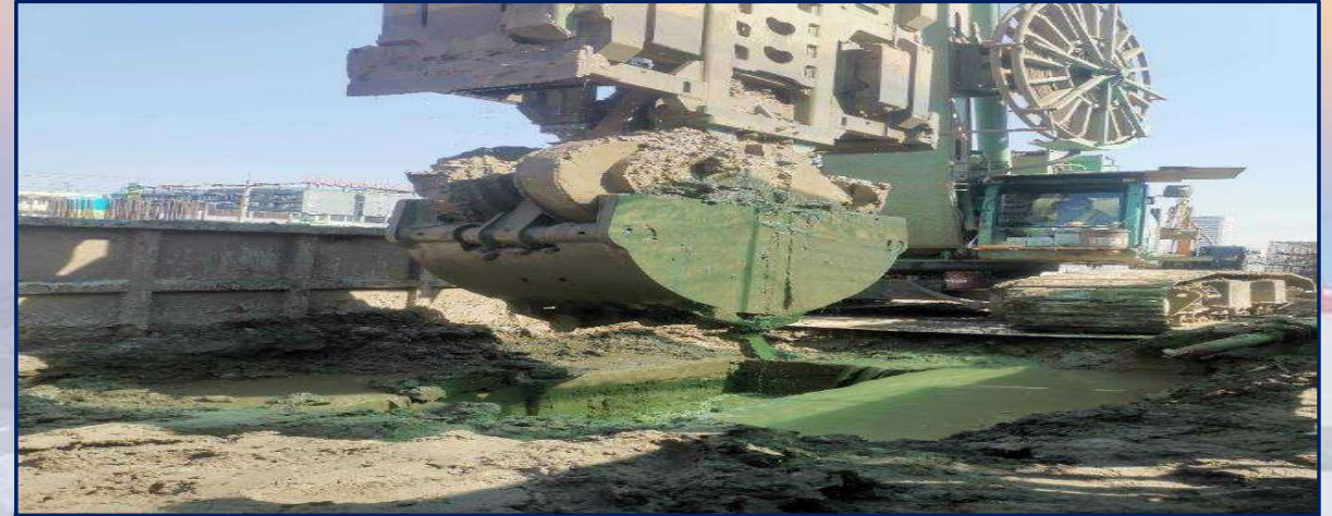
เจาะเสาเข็มรูปสี่เหลี่ยม 1.00x3.80 ม. MLP11-19L No.1
