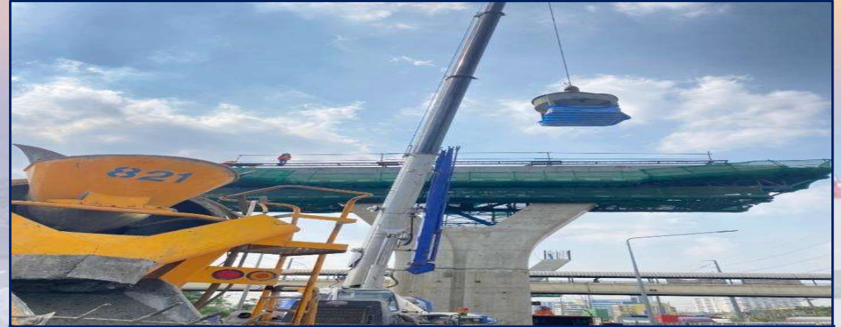
เทคอนกรีต Bearing Plinth ที่ MLP10-07
