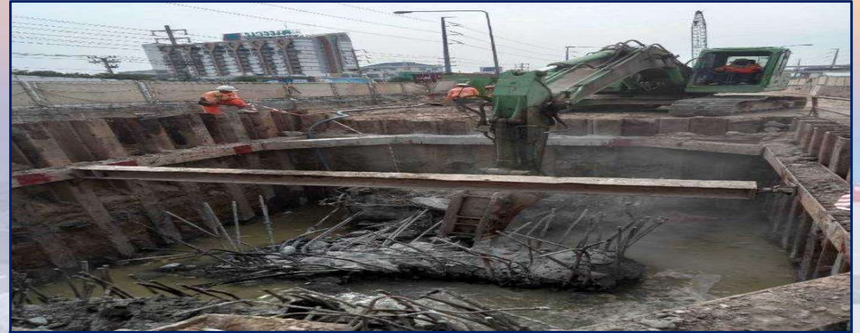
สกัดคอนกรีตหัวเสาเข็ม MLP09-11
