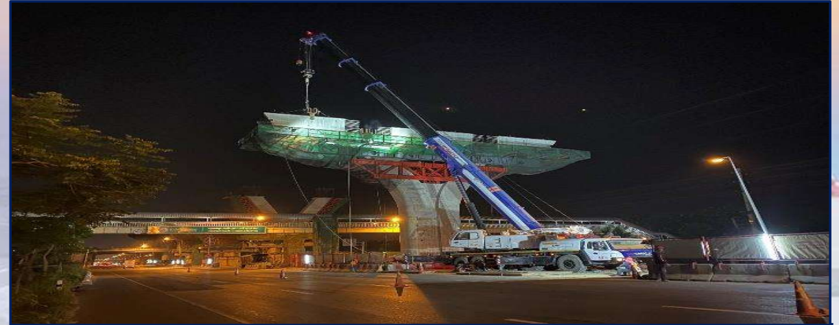
ติดตั้งคานคอนกรีตอัดแรง MLP06-17 (Pre-cast Crosshead)
