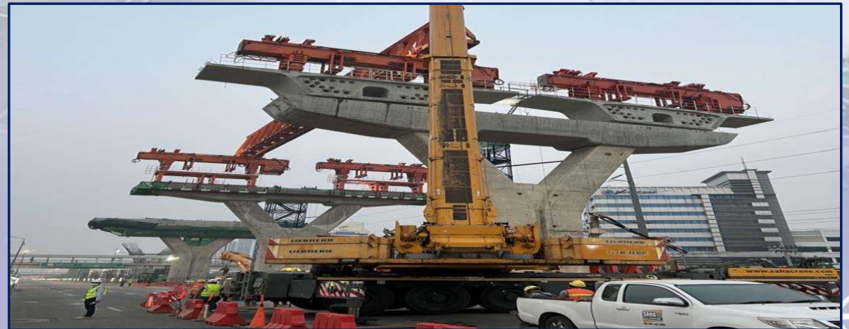
ติดตั้ง Launching Gantry LG8 ที่ MLP10-07 to MLP10-08
