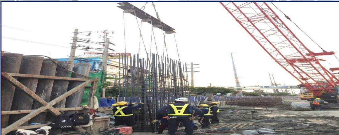
ลงเหล็กเสริมเสาเข็มเจาะรูปสี่เหลี่ยม 1.00x3.00 ม. MLP11-11R No.1
