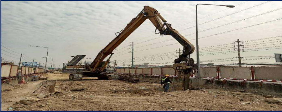
ติดตั้ง Sheet Pile MLP07-14
