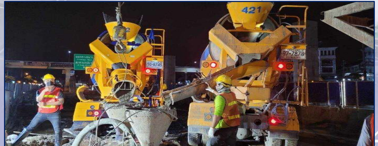
เทคอนกรีตเสาเข็มเจาะรูปสี่เหลี่ยม 1.00x3.00 ม. MLP11-11R No.1
