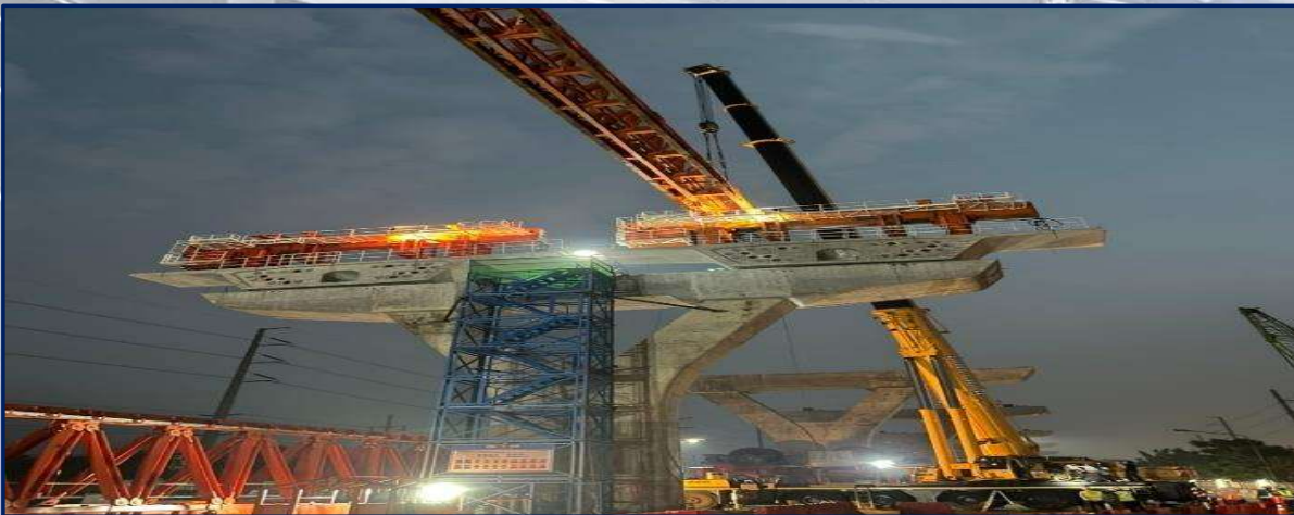
ติดตั้ง Launching Gantry LG8 ที่ MLP10-07 to MLP10-08
