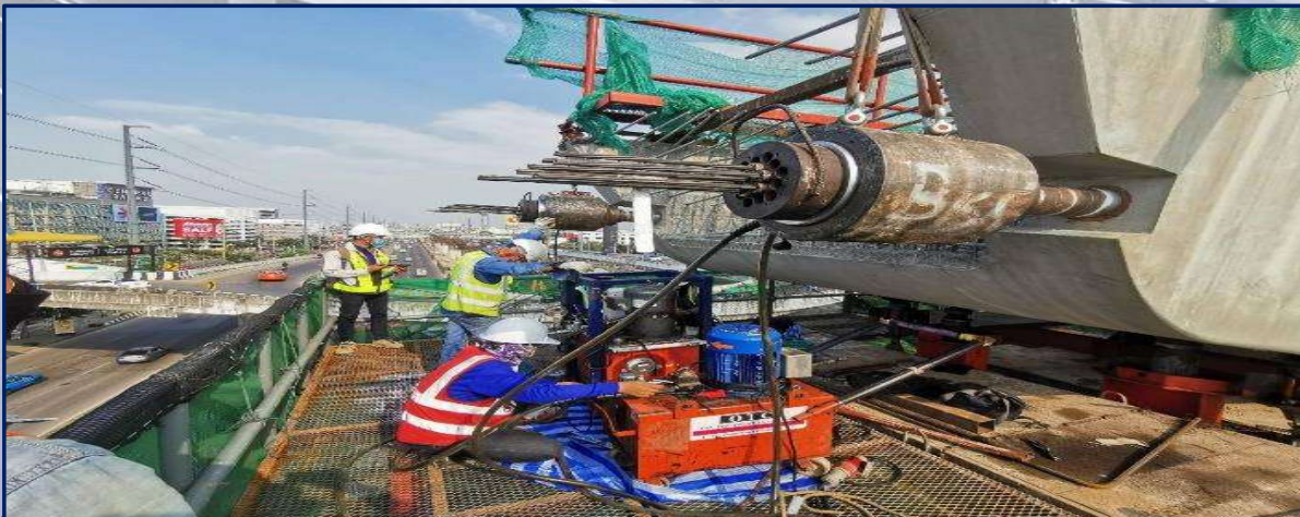
ดึงลวดขึ้นส่วนเปลือกคานคอนกรีตอัดแรง MLP06-21
