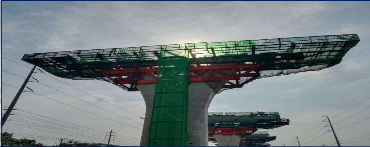
ติดตั้ง Support คานคอนกรีตอัดแรง MLP06-17
