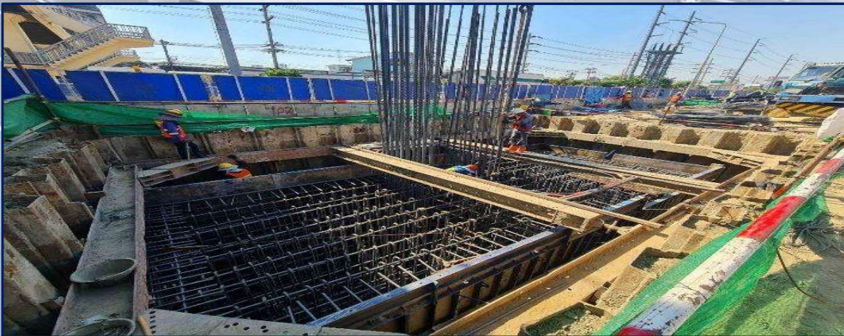
ติดตั้งเหล็กเสริมฐานราก MLP11-07
