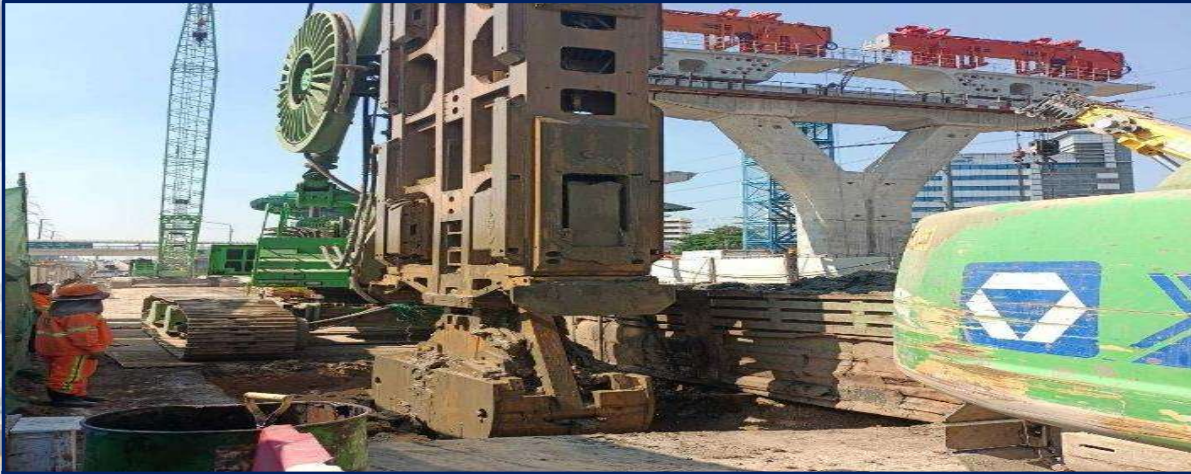
เจาะเสาเข็มรูปสี่เหลี่ยม 1.00x3.00 ม. RON4-02 No.2
