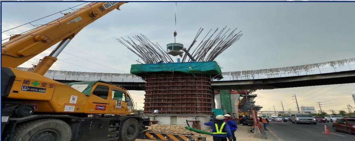
เทคอนกรีตเสาดอม่อ MLP06-22 Step-2
