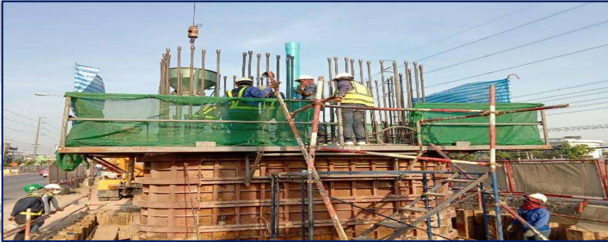
เทคอนกรีตเสาดอม่อ MLP07-15 Step-1
