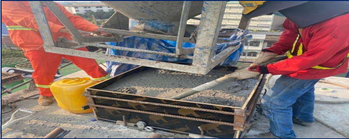
เทคอนกรีต Bearing Plinth ที่ MLP10-13
