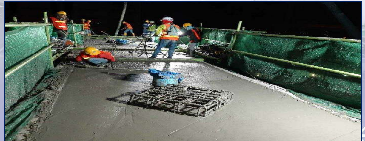
เทคอนกรีตคานคอนกรีตอัดแรง MLP10-05
