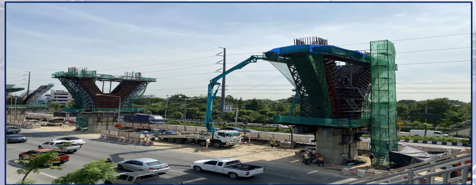
เทคอนกรีตเสาตอม่อ MLP06-18 Step-3
