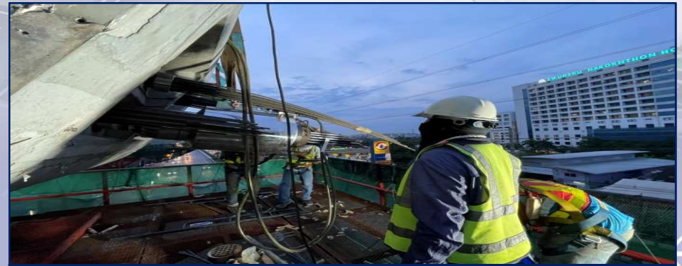
ติดตั้งคานคอนกรีตอัดแรง MLP06-14
