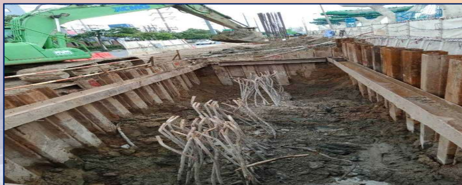
สกัดคอนกรีตหัวเสาเข็ม ROF4-13
