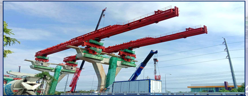
ติดตั้ง Launching Gantry LG1 & LG2 ที่ MLP06-11 to MLP06-12
