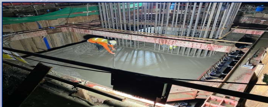
เทคอนกรีตฐานราก MLP11-02
