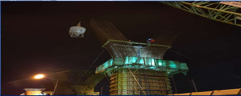
เทคอนกรีตเสาตอม่อ MLP08-19 Step-2
