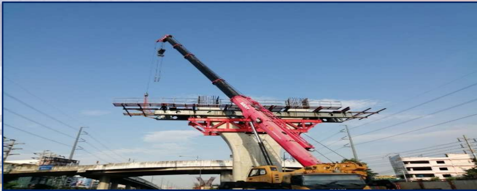
ติดตั้ง Support คานคอนกรีตอัดแรง MLP06-21
