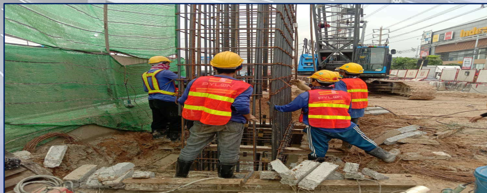
ลงเหล็กเสริมเสาเข็มเจาะรูปสี่เหลี่ยม 1.00x3.00 ม. MLP07-24L No.1
