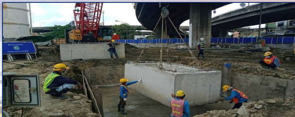
ติดตั้งผนังนำร่องเสาเข็ม MLP11-22L
