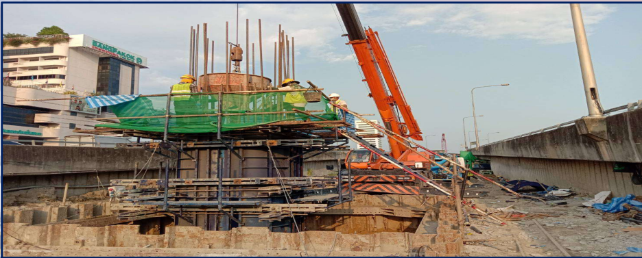
ติดตั้งเหล็กเสริมเสาตอม่อ MLP11-11 Step-1
