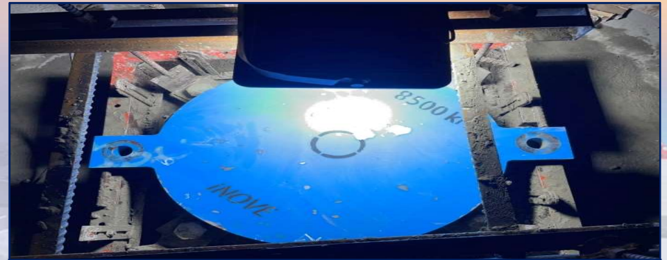
Grout Bottom Plate of Pot Bearing ที่ MLP06-13
