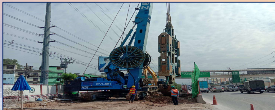
เจาะเสาเข็มรูปสี่เหลี่ยม 1.00x3.00 ม. MLP07-24L No.1
