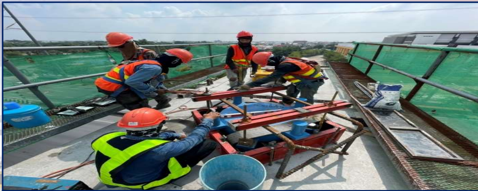
ติดตั้ง Pot Bearing ที่ MLP06-12
