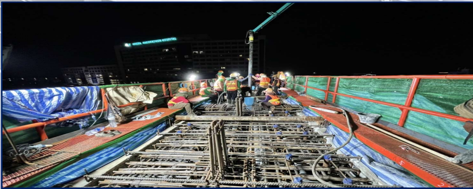
เทคอนกรีตคานคอนกรีตอัดแรง MLP06-15
