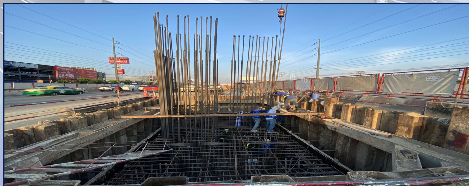
ติดตั้งเหล็กเสริมฐานราก MLP06-15
