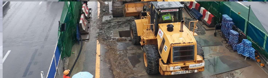
งานเจาะเสาเข็ม Barrette Pile 1.00x3.80 m. MLP08-11C No.2
