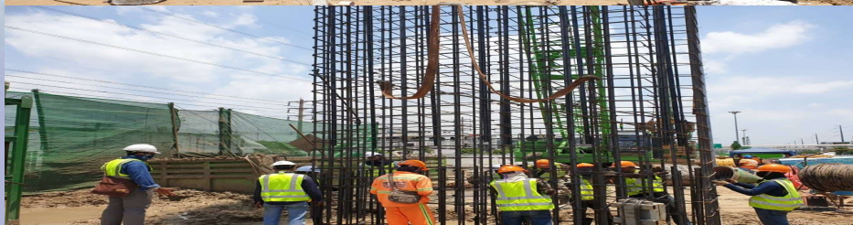
งานลงเหล็ก Barrette Pile 1.00x3.80 m. MLP08-09C No.1
