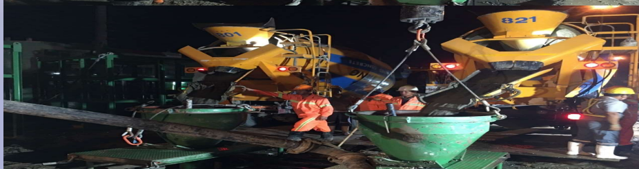
งานเทคอนกรีต Barrette Pile 1.00x3.80 m. MLP08-11C No.2
