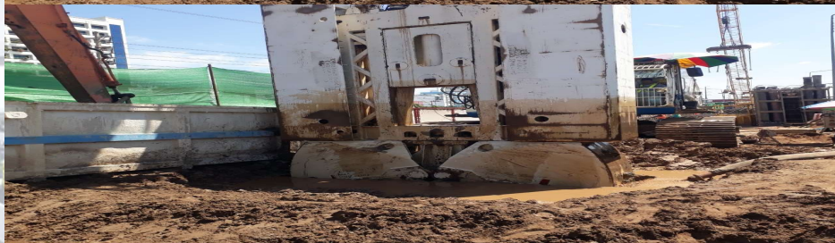
งานเจาะเสาเข็ม Barrette Pile 1.00x3.80 m. MLP06-15 No.2
