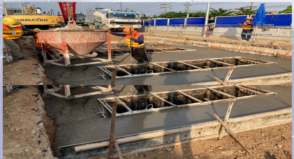
งานเทคอนกรีตยึดผนังนำร่องเสาเข็มเจาะ MLP10-18
