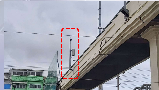
จุดที่ 5 STA.11+155
