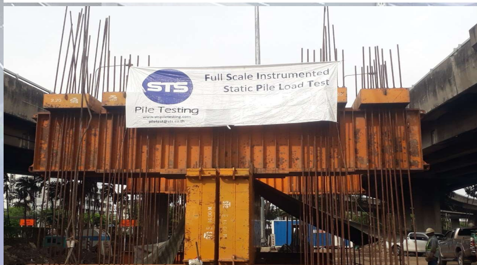
งานทดสอบเสาเข็ม Barrette Pile 1.00x3.80 m.
