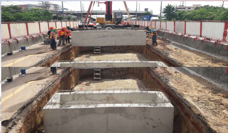
งานติดตั้งผนังนำร่องเสาเข็มเจาะ MLP06-19
