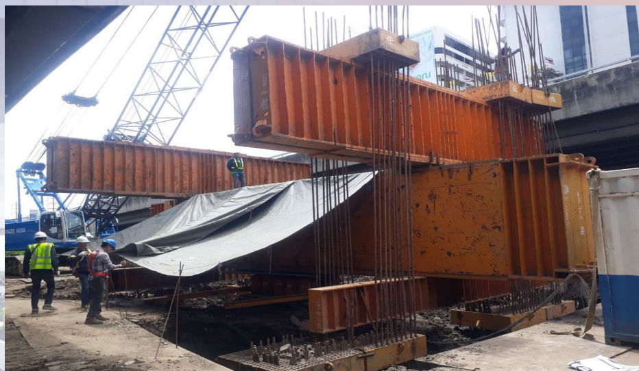
งานทดสอบเสาเข็ม Barrette Pile 1.00x3.00 m.
