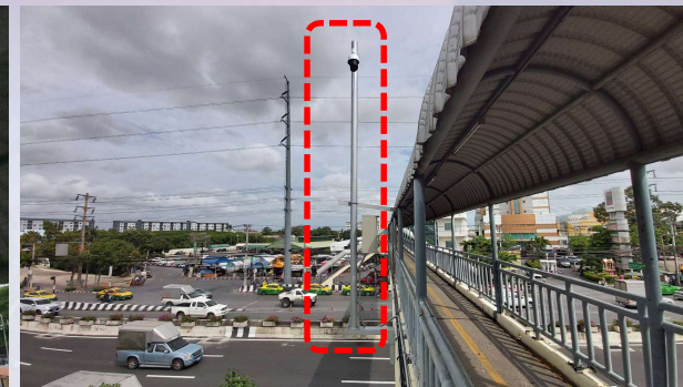
จุดที่ 3 STA.9+262
