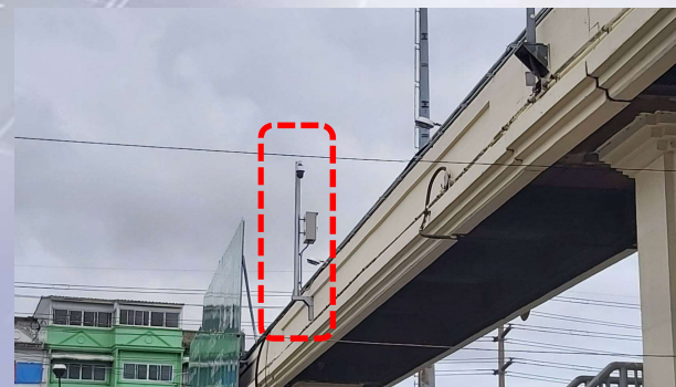
จุดที่ 5 STA.11+155
