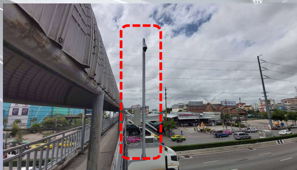
จุดที่ 4 STA.10+063
