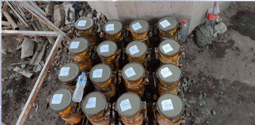
งานเทคอนกรีตเสาเข็ม Anchorage Pile No. 2
