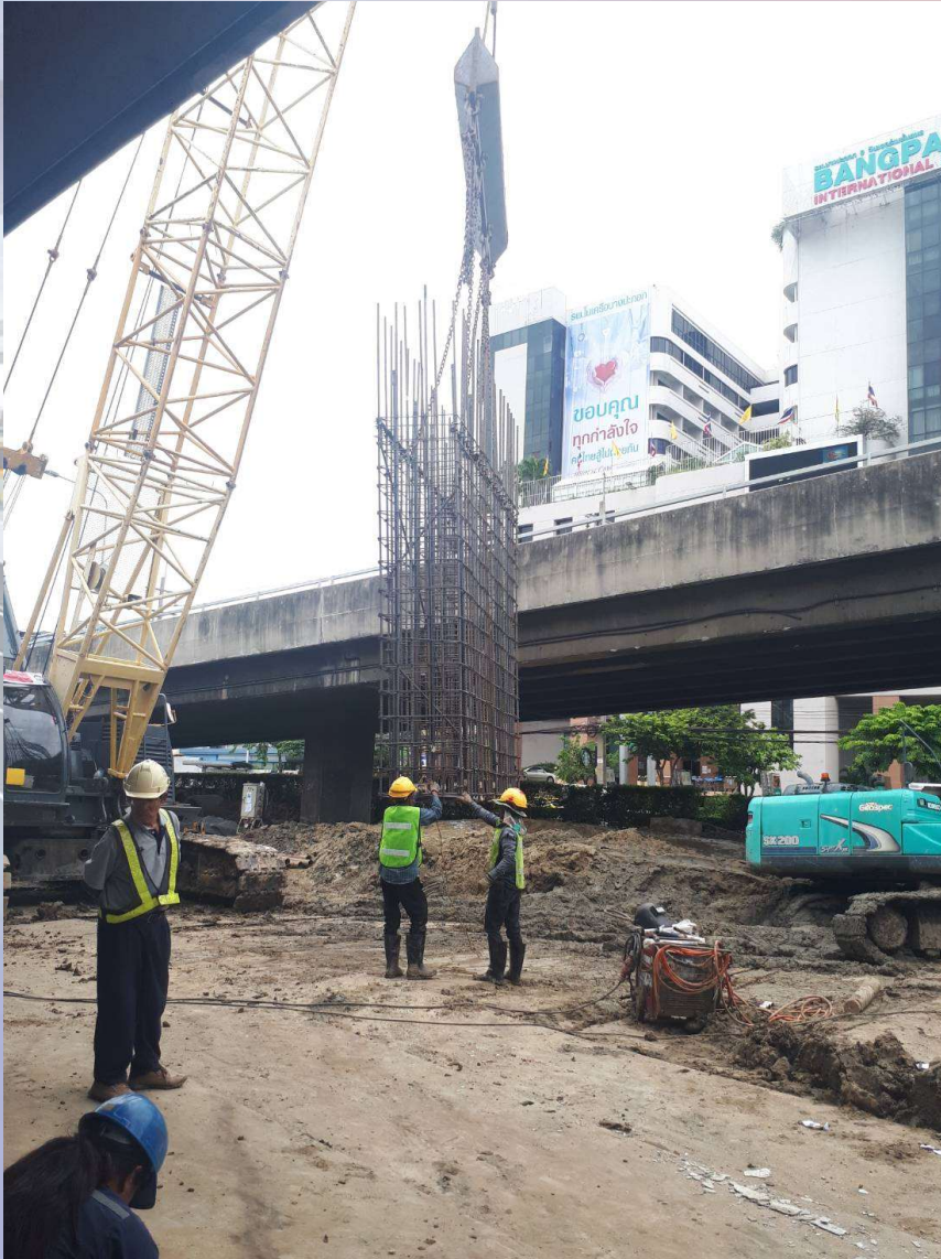
งานติดตั้งเหล็กเสริม และอุปกรณ์ตรวจวัดค่าความเครียดของเสาเข็ม Pilot Pile (Barrette Pile size 1.0 x 3.8 m.)
