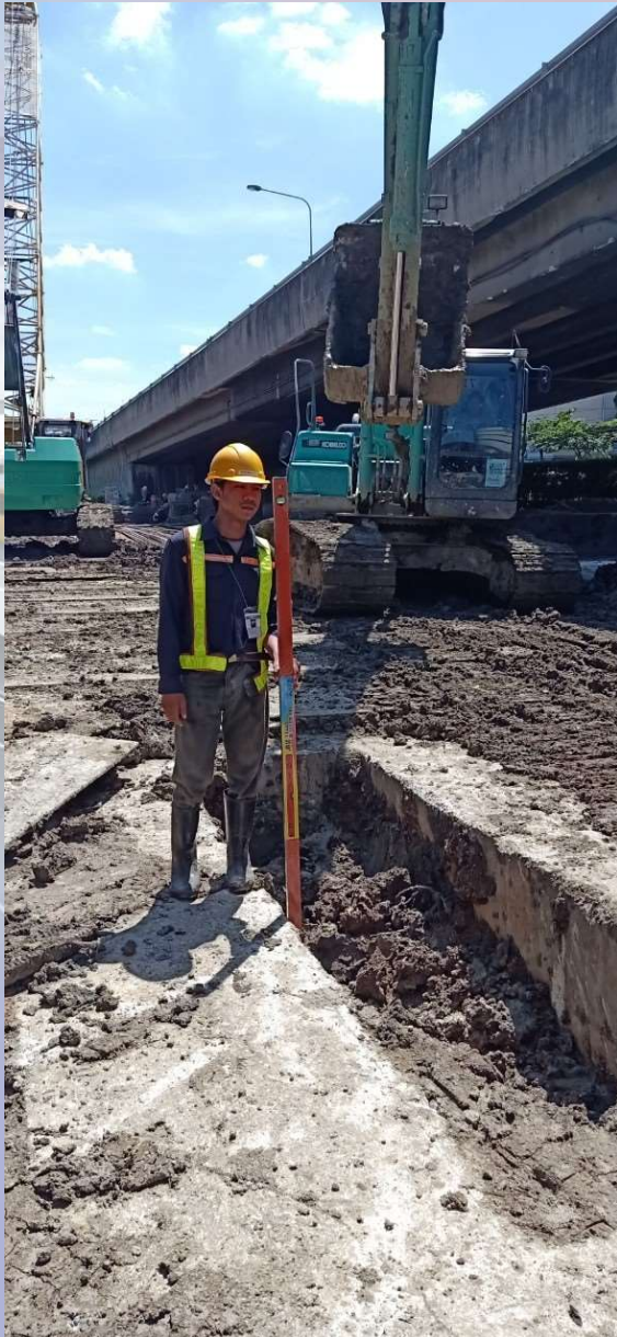
งานเจาะเสาเข็ม Pilot Pile (Barrette Pile size 1.0 x 3.8 m.)
