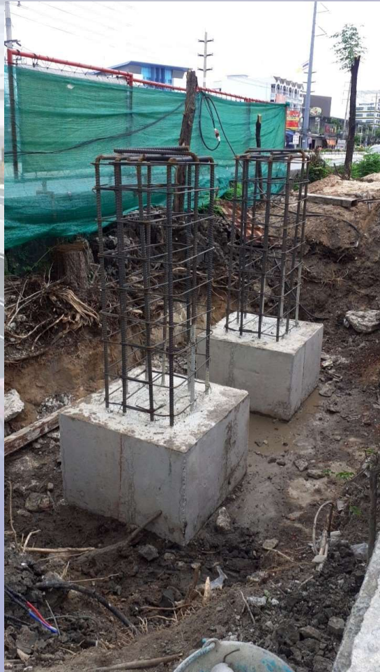
งานก่อสร้างฐานราก และเสาตอม่อโครงสร้างป้าย VMS
