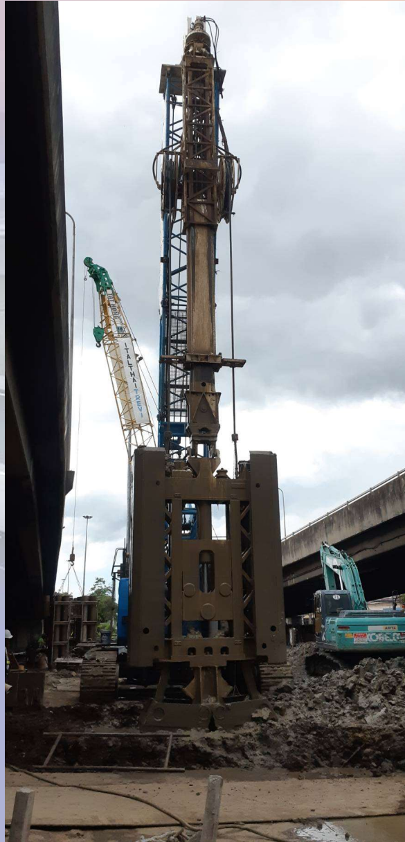
งานเจาะเสาเข็ม Anchorage Pile No. 2
