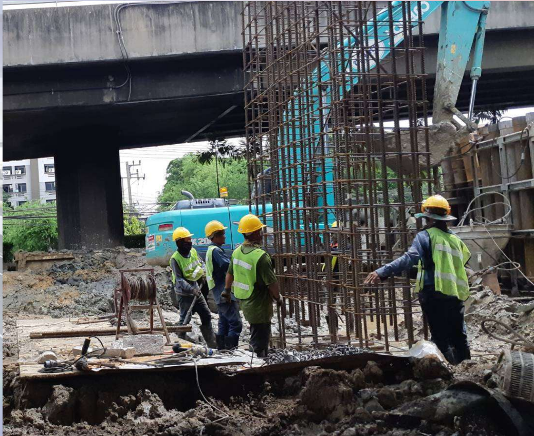
งานติดตั้งเหล็กเสริมเสาเข็ม Anchorage Pile No. 2
