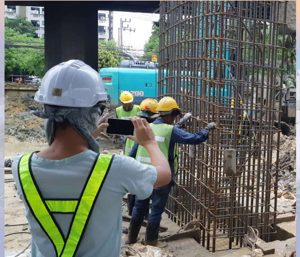
งานติดตั้งเหล็กเสริมเสาเข็ม Anchorage Pile No. 2
