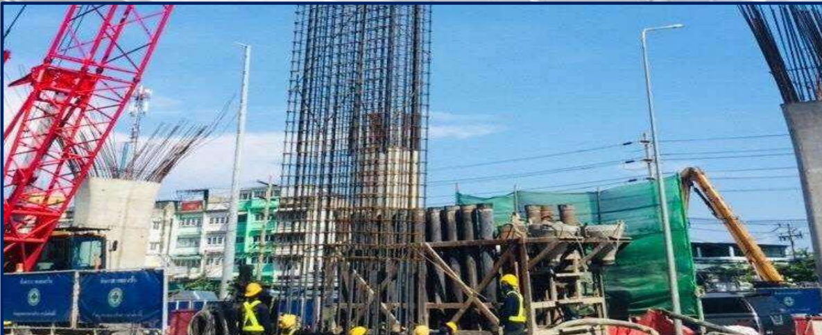
ลงเหล็กเสาเข็มเจาะรูปสี่เหลี่ยม 1.00x3.00 ม. MLP11-05R No.1
