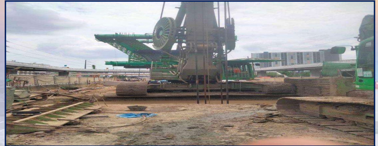
เจาะเสาเข็มรูปสี่เหลี่ยม 1.00x3.80 ม. MLP09-23 No.1
