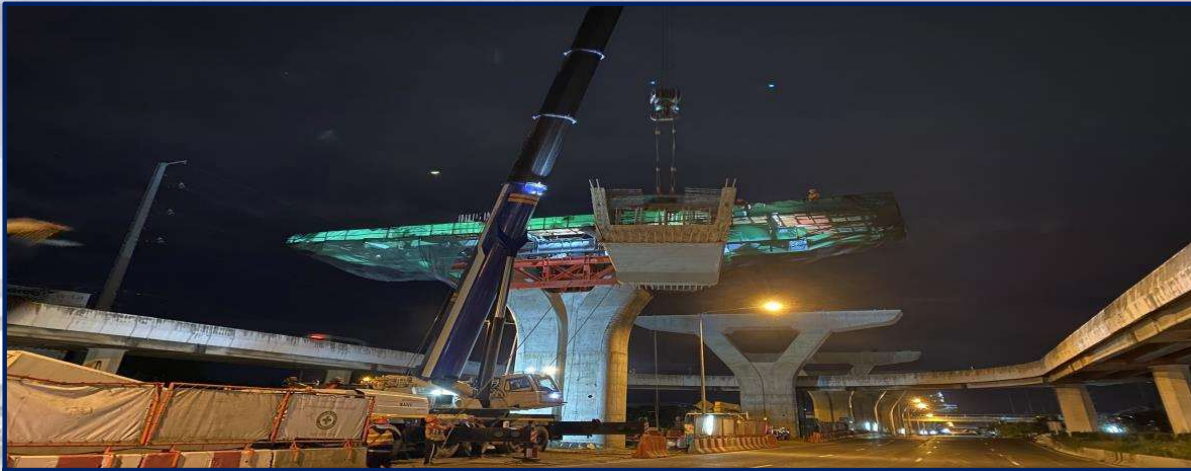
ติดตั้งชิ้นส่วนคานคอนกรีตอัดแรง (Precast) MLP06-23
