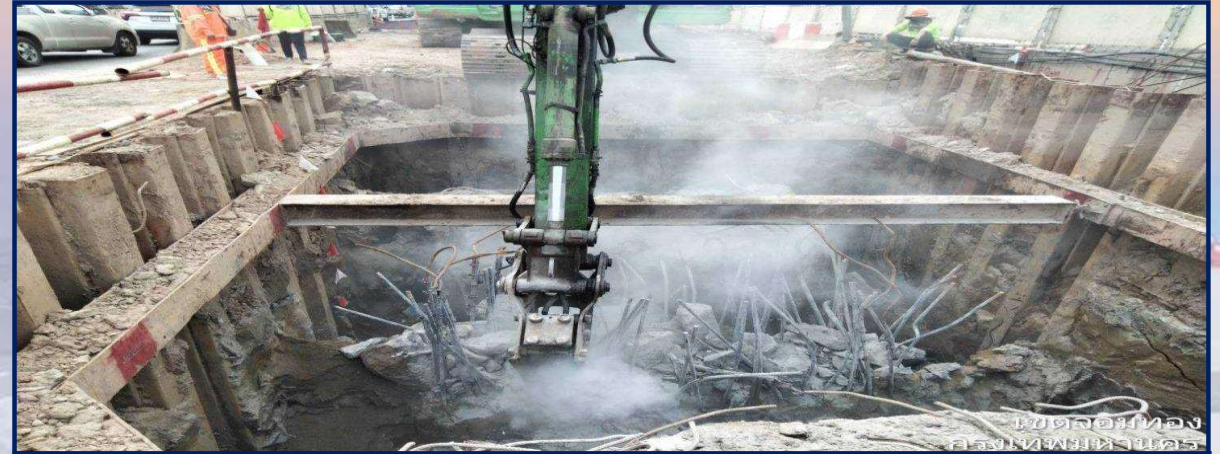
สกัดคอนกรีตหัวเสาเข็มงานฐานราก MLP09-06
