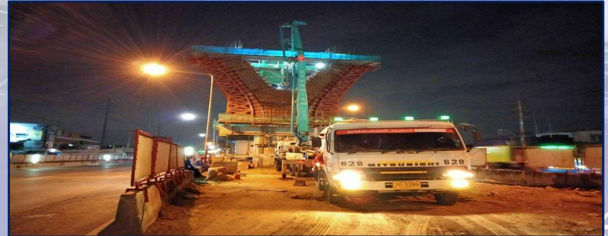
เทคอนกรีตเสาตอม่อ MLP07-17 Step-3
