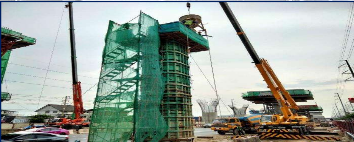
เทคอนกรีตเสาตอม่อ RON3-07 Step-2
