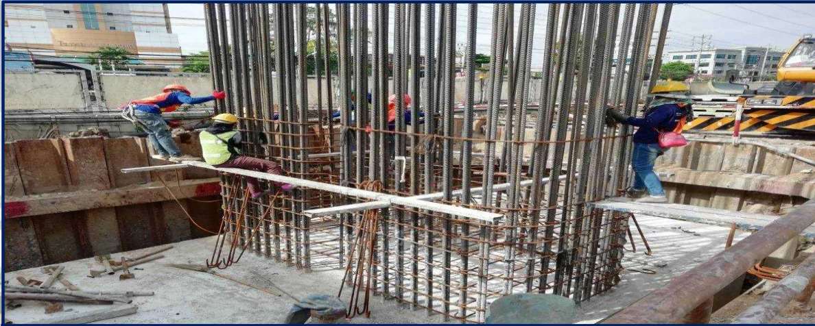
ติดตั้งเหล็กเสริมเสาตอม่อ MLP09-07 Step-1
