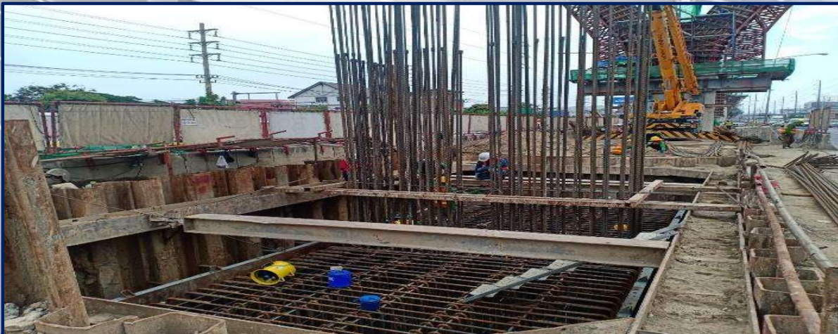
ติดตั้งเหล็กเสริมฐานราก MLP07-24C
