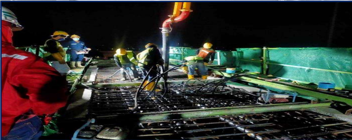
เทคอนกรีตคานคอนกรีตอัดแรง (In fill) MLP09-03
