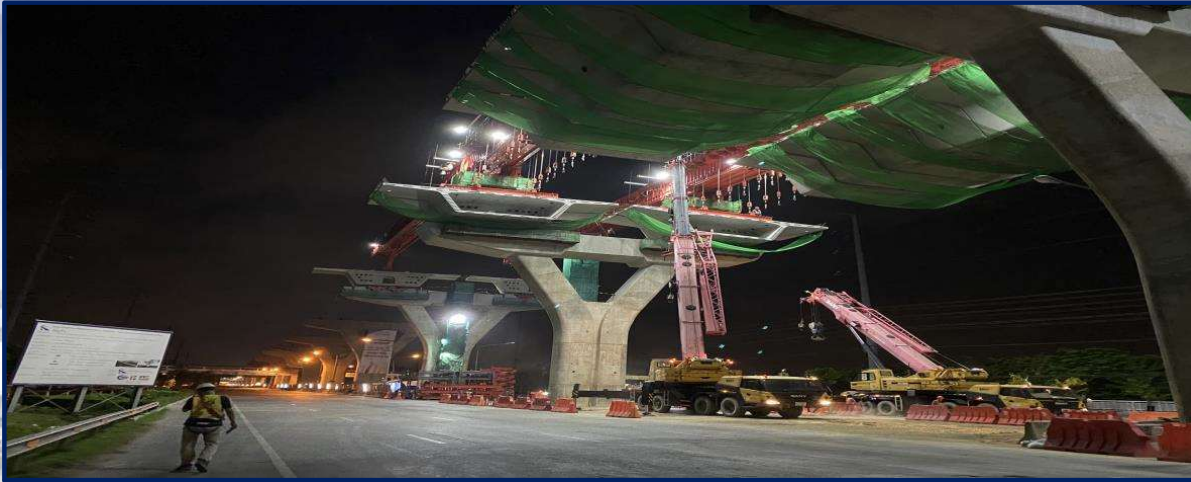
ยกติดตั้ง Segment MLP06-12 To MLP06-13
