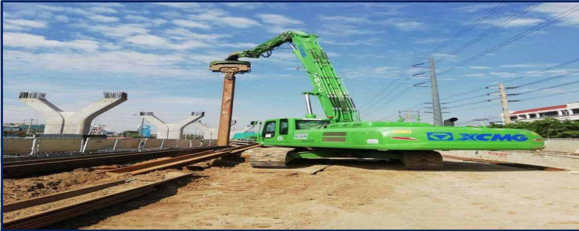
ติดตั้ง Sheet Pile ฐานราก ROF3-19
