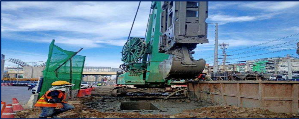
เจาะเสาเข็มรูปสี่เหลี่ยม 1.00x3.00 ม. MLP11-04R No.2
