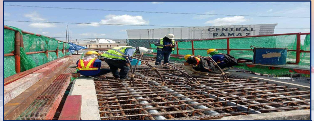
ติดตั้งเหล็กเสริมคานคอนกรีตอัดแรง (In fill) MLP07-04
