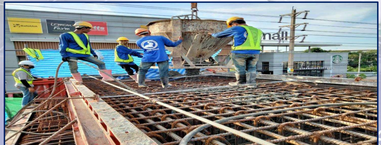
เทคอนกรีต Cross head RON3-05
