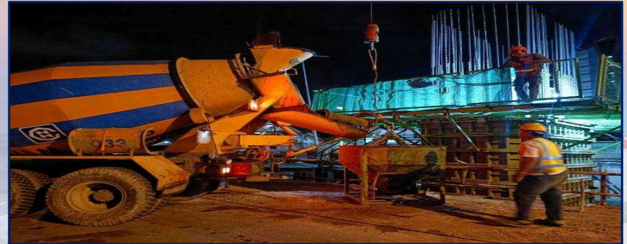
เทคอนกรีตเสาตอม่อ MLP09-06 Step-1
