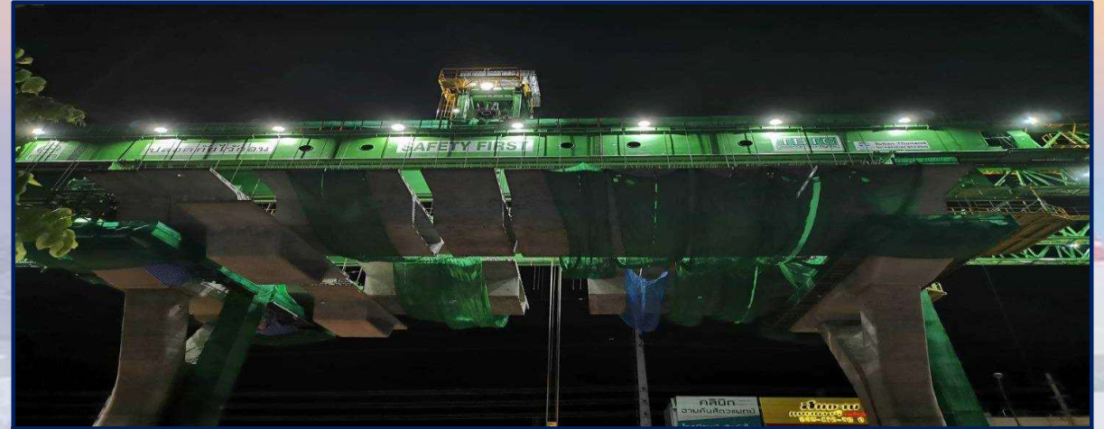
ยกติดตั้ง Segment MLP08-17 To MLP08-18
