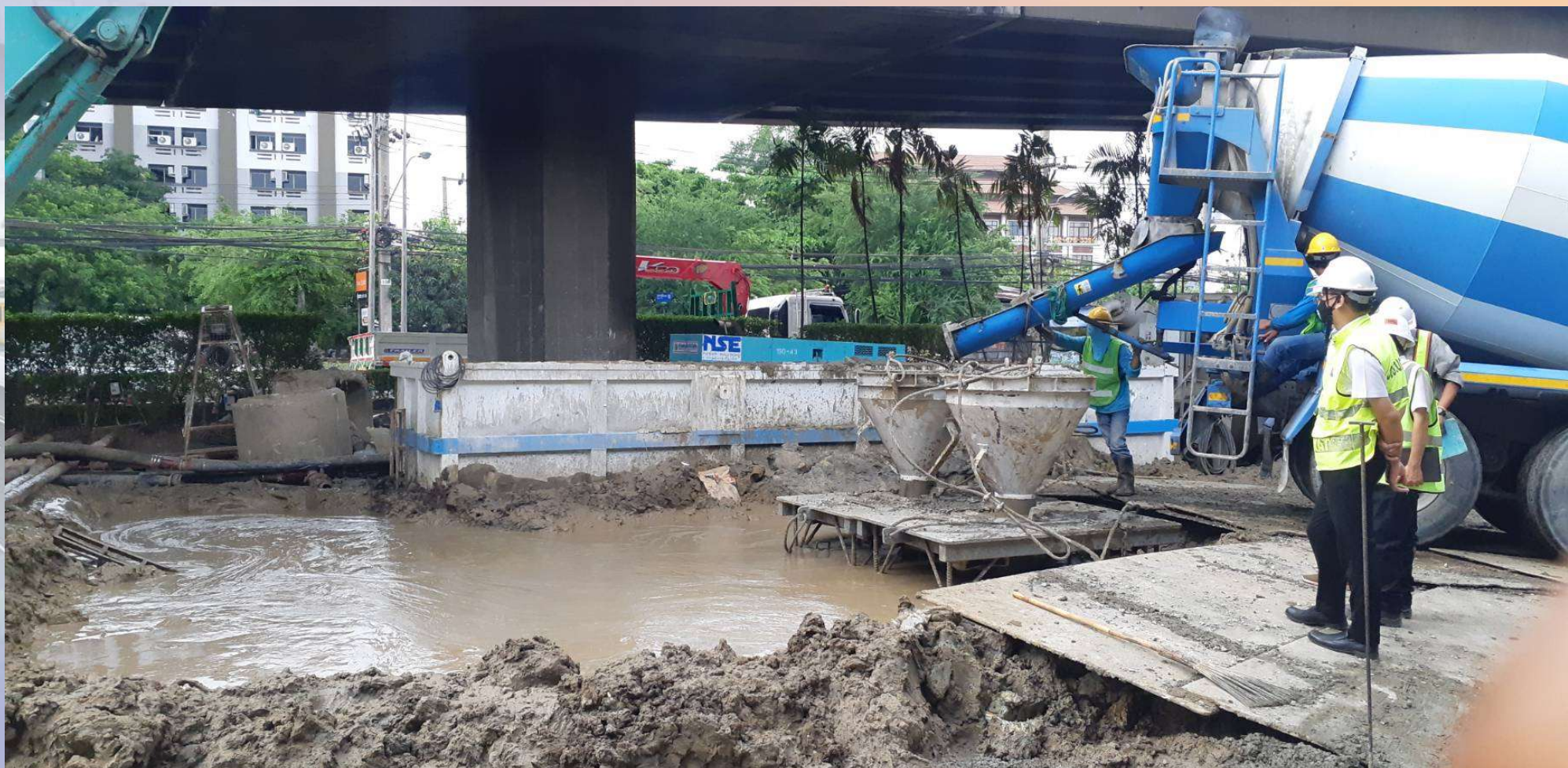
งานเทคอนกรีตเสาเข็ม Anchorage Pile No. 1
