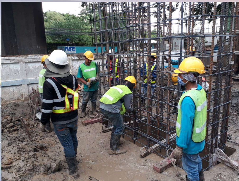
งานติดตั้งเหล็กเสริม งานเสาเข็ม Anchorage Pile No. 1
