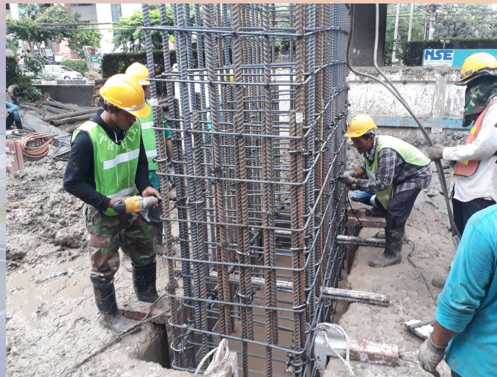
งานติดตั้งเหล็กเสริม งานเสาเข็ม Anchorage Pile No. 1
