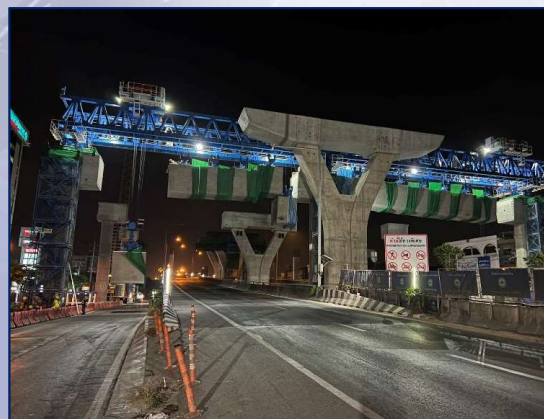
ติดตั้ง Portal Beam ที่ RON5-16
