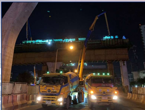
เทคอนกรีต Portal Beam MLP09-17
