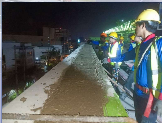
งาน I-Girder & C-Girder, งานกำแพงกันตก (Parapet)
