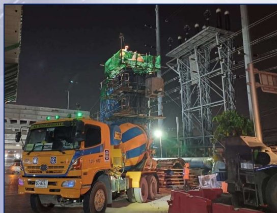
เทคอนกรีตเสาตอม่อ ROF5-14 Step-2
