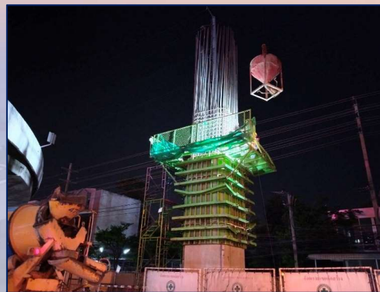
เทคอนกรีตเสาตอม่อ RON4-15 Step-2
