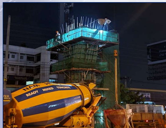
เทคอนกรีตเสาตอม่อ MLP07-31R Step-2
