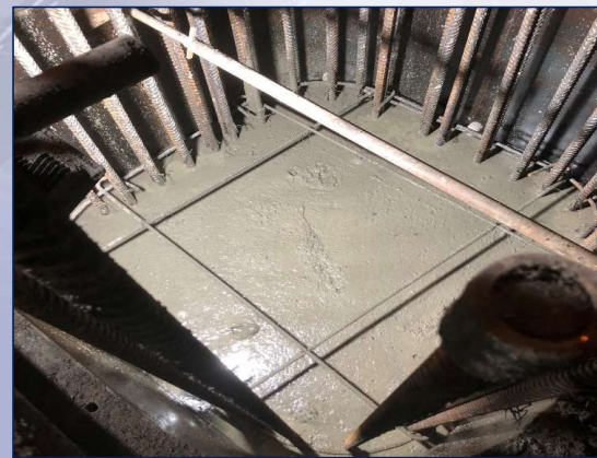
เทคอนกรีตเสาตอม่อ MLP11-22L Step-2
