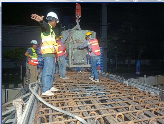
เทคอนกรีต Cross beam ที่ ROF4-16
