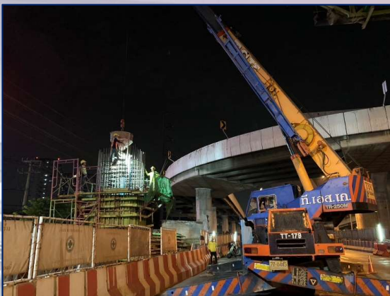
เทคอนกรีตเสาตอม่อ ROF4-03 Step-1
