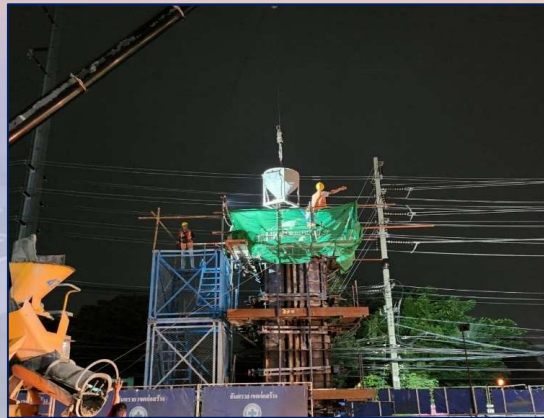
เทคอนกรีตเสาตอม่อ RON5-04 Step-2
