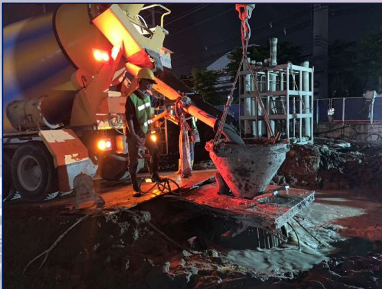
เทคอนกรีตเสาเข็มเจาะ Bored Pile ROF5-20E No.2
