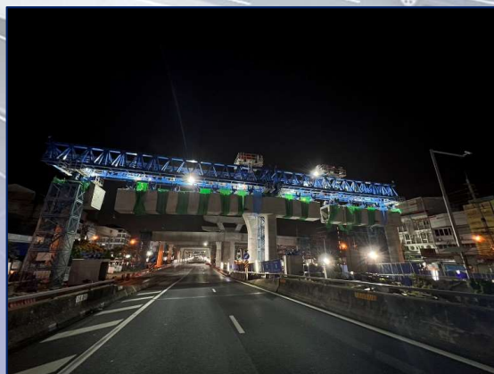
ติดตั้ง Portal Beam ที่ RON5-15
