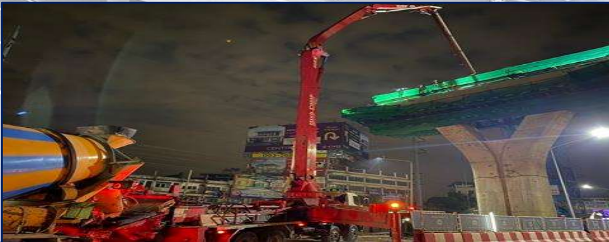
เทคอนกรีตคานคอนกรีตอัดแรง (In fill) MLP10-22
