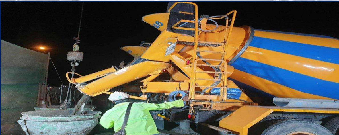
เทคอนกรีตเสาเข็มเจาะรูปสี่เหลี่ยม 1.00x3.80 ม. MLP10-02RT No.1
