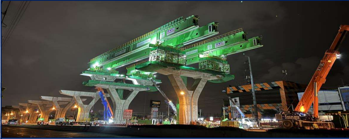
ยกติดตั้ง Launching Gantry ที่ MLP08-17 To MLP08-18
