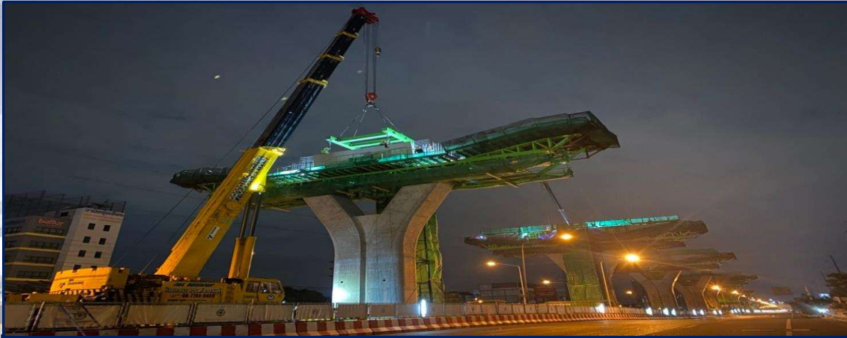
ติดตั้งชิ้นส่วนคานคอนกรีตอัดแรง (Precast) MLP08-24
