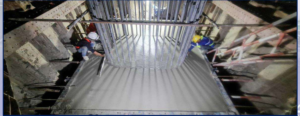
เทคอนกรีตฐานราก MLP11-06C
