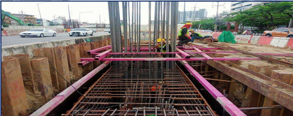
ติดตั้งเหล็กเสริมฐานราก MLP10-02L
