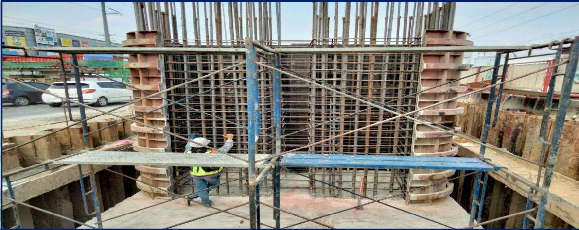
ติดตั้งเหล็กเสริมเสาตอม่อ MLP07-18 Step-1
