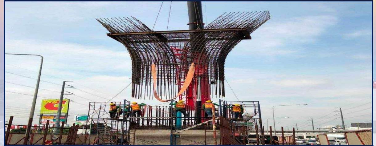
ติดตั้งเหล็กเสริมเสาตอม่อ MLP07-11 Step-2
