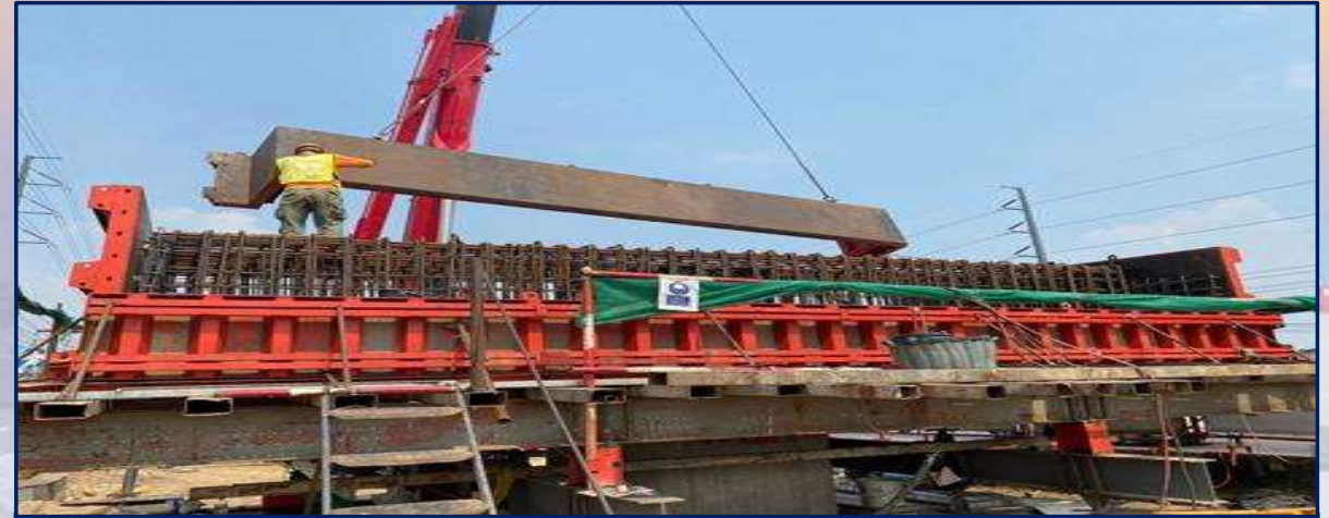
ติดตั้งแบบหล่อ Cross head RON3-02
