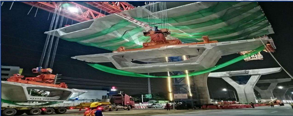
ยกติดตั้ง Segment MLP10-07 To MLP10-08
