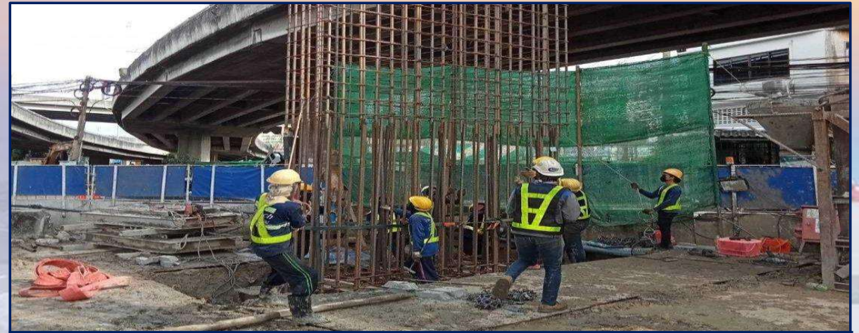
ลงเหล็กเสาเข็มเจาะรูปสี่เหลี่ยม 1.00x3.80 ม. MLP11-23C No.4
