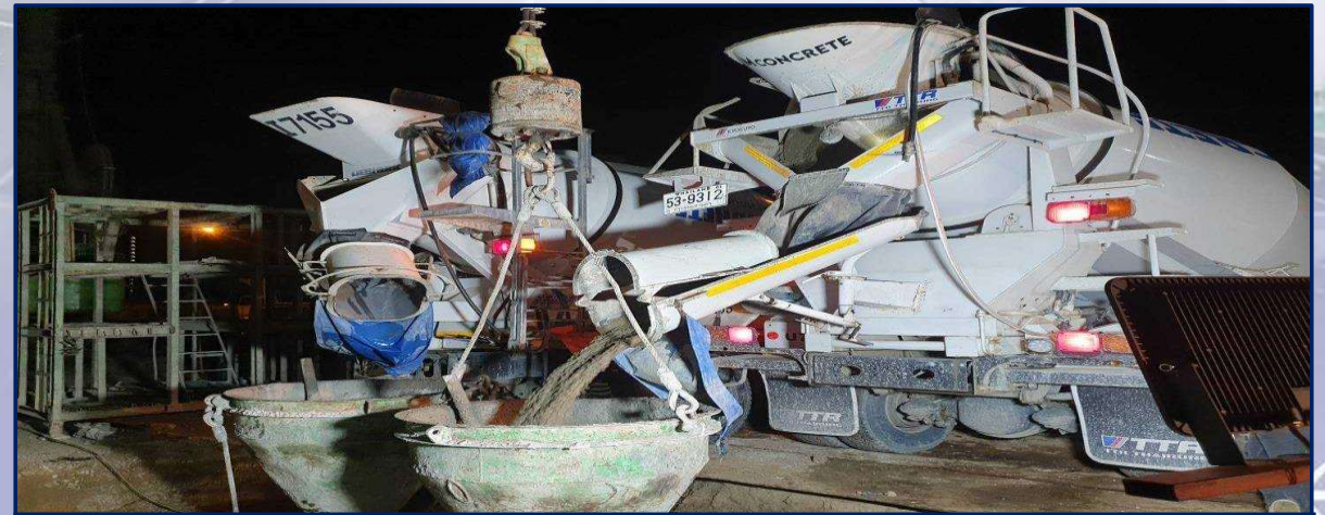
เทคอนกรีตเสาเข็มเจาะรูปสี่เหลี่ยม 1.00x3.00 ม. MLP10-03R No.1
