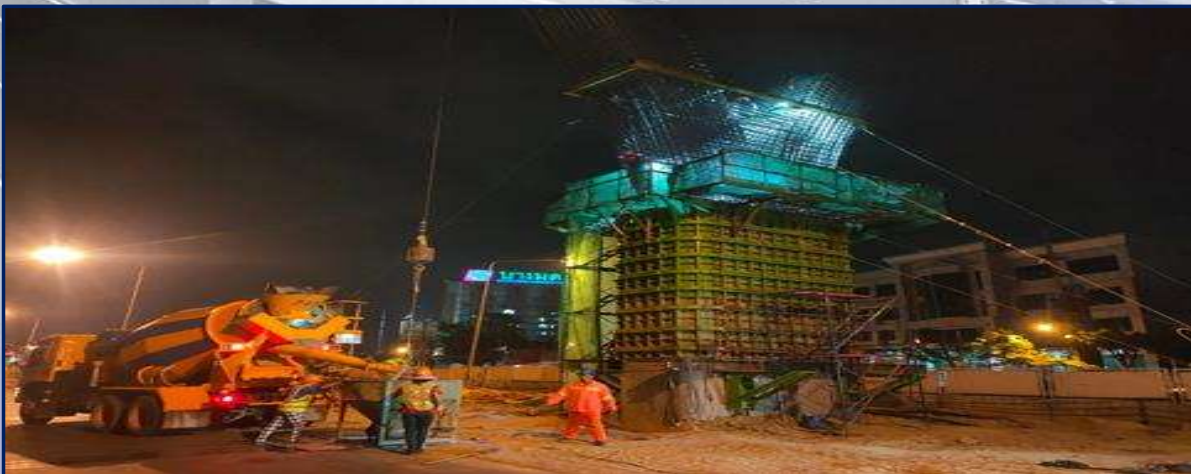
เทคอนกรีตเสาตอม่อ MLP09-02 Step-2
