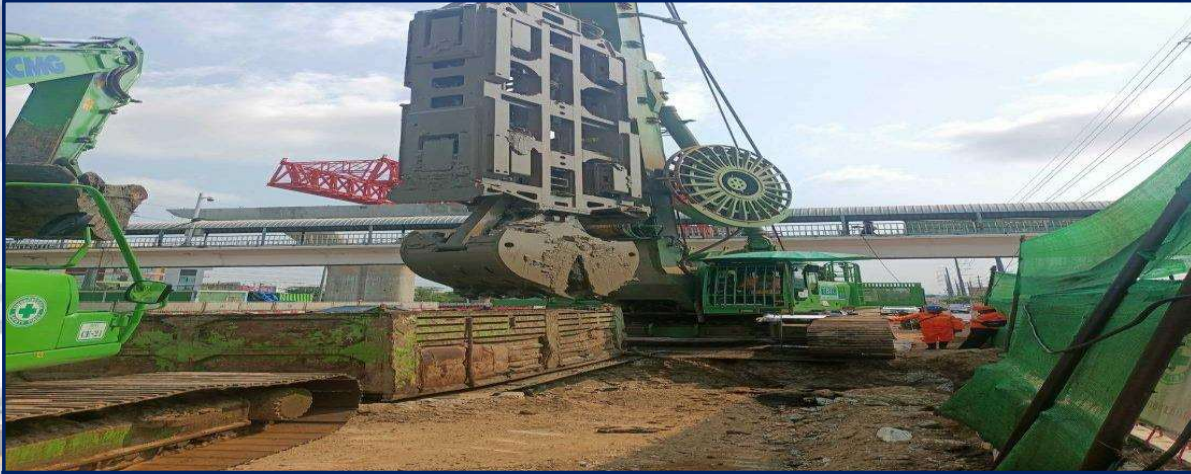
เจาะเสาเข็มรูปสี่เหลี่ยม 1.00x3.00 ม. MLP10-03R No.1
