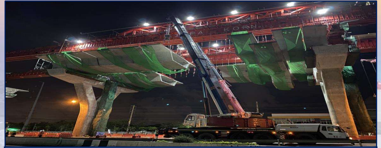
ยกติดตั้ง Segment MLP06-11 To MLP06-12
